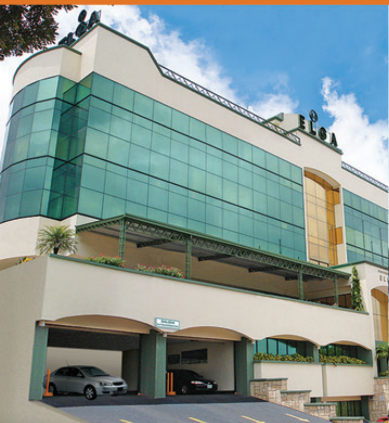
TEGUCIGALPA, Oficina Principal Alameda
